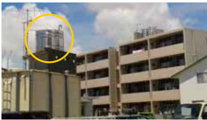
マンション屋上に設置された給水タンク
